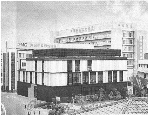
手前が新設されたE館
