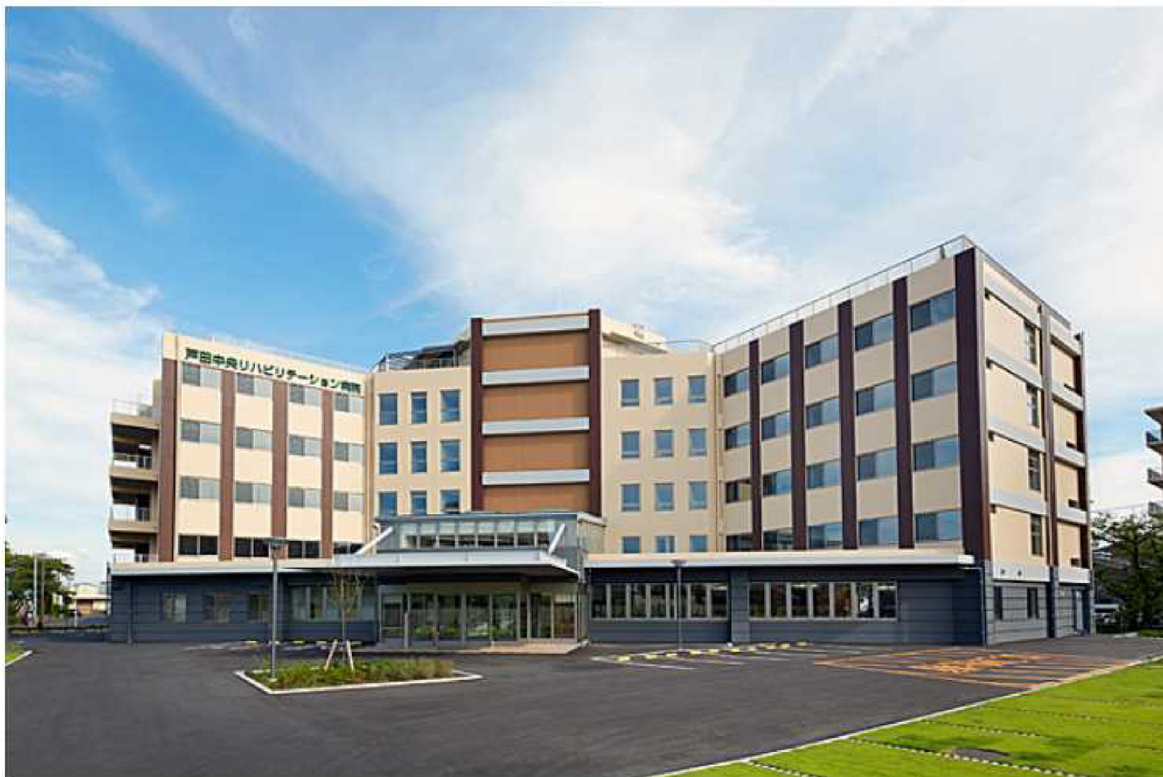
移転新築した戸田中央リハビリテーション病院
