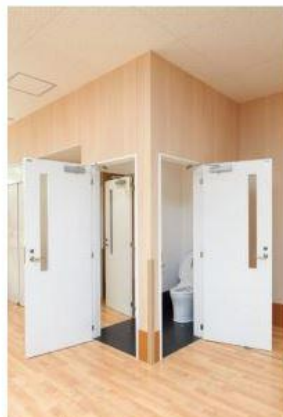
自宅の環境に対応する3方向にドアが開くトイレも設置された
