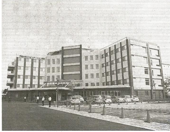
新築移転した戸田中央リハビリテーション病院
