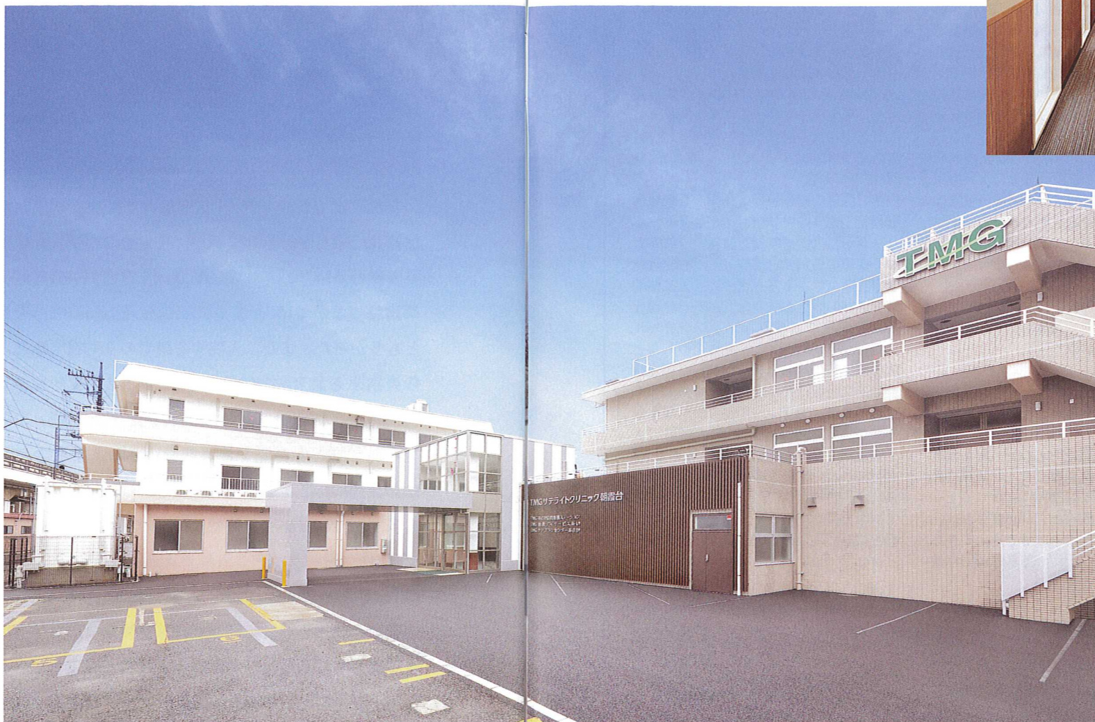
1日にリニューアルオープンした「TMGサテライトクリニック朝霞台」。建物の右側が医療サービスを提供するA棟、左が介護サービス事業所が入るB棟
