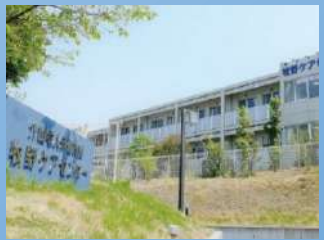
【横浜市神奈川区】 牧野ケアセンター (介護老人保健施設)
